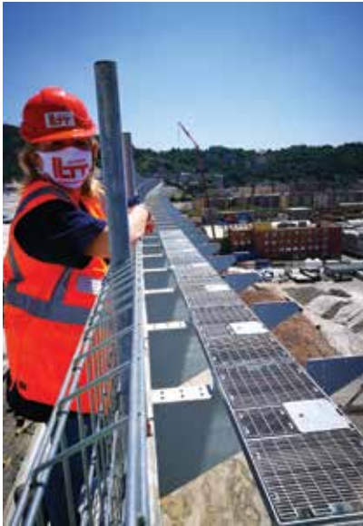
Claudia Gallone, vice rup ricostruzione - Struttura Commissariale per la Ricostruzione del Viadotto Polcevera
