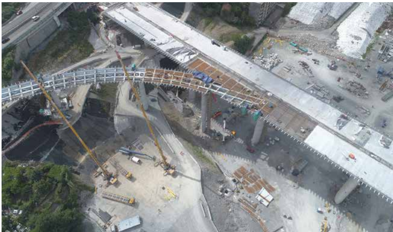
Foto dell'avanzamento lavori, foto courtesy Commissario Ricostruzione Genova
