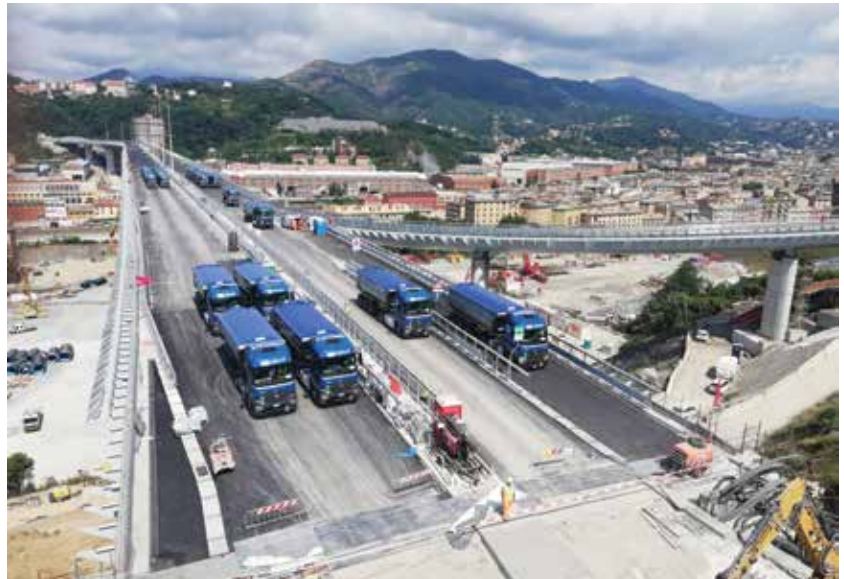
Collaudo, foto courtesy Commissario Ricostruzione Genova
